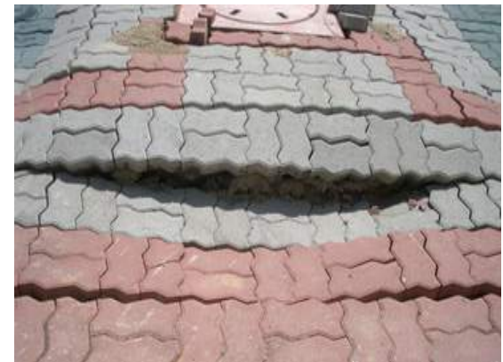
토사유출에 의한 흙막이 배면 지반침하 발생
